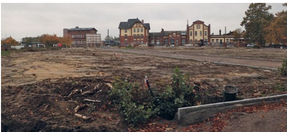
Stadt Burg: Das Gelände der ehemaligen städtischen Gasanstalt Burg wurde mit Fördermitteln aus dem EU-Regionalfonds saniert und zur Landesgartenschau 2018 in den Goethepark integriert.
