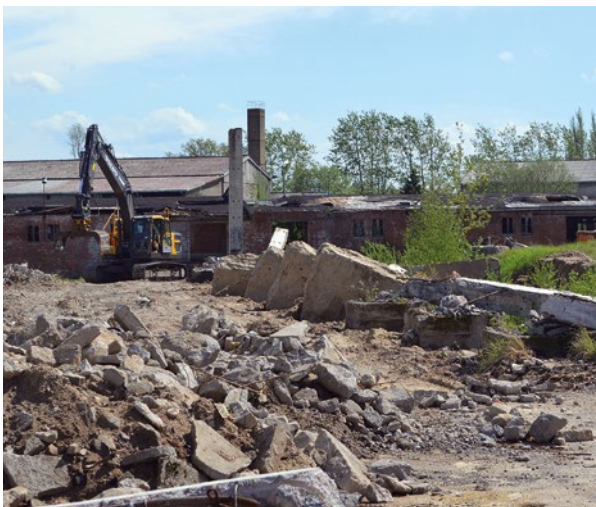
Rückbauprogramm devastierter Flächen am Beispiel Goldberg. Vorher: Abriss ruinöser Industriegebäude und Flächensanierung (links); nachher: Nutzung durch eine Fotovoltaikanlage (rechts)
