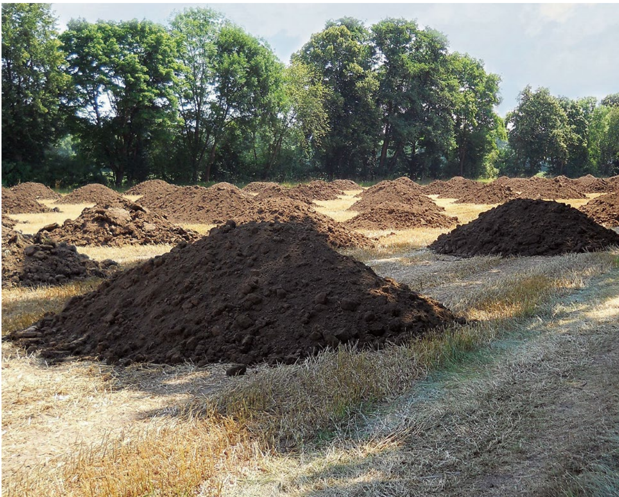
Beispielhafter Auftrag von locker abgelagertem humosem Oberboden auf trockenem Oberboden einer Ackerfläche zur landwirtschaftlichen Bodenverbesserung. Die kleinräumige Verteilung des Oberbodens ermöglicht eine bodenschonende Ausbreitung durch Maschinen mit geringem Bodendruck bei kurzen Verteilungswegen.
