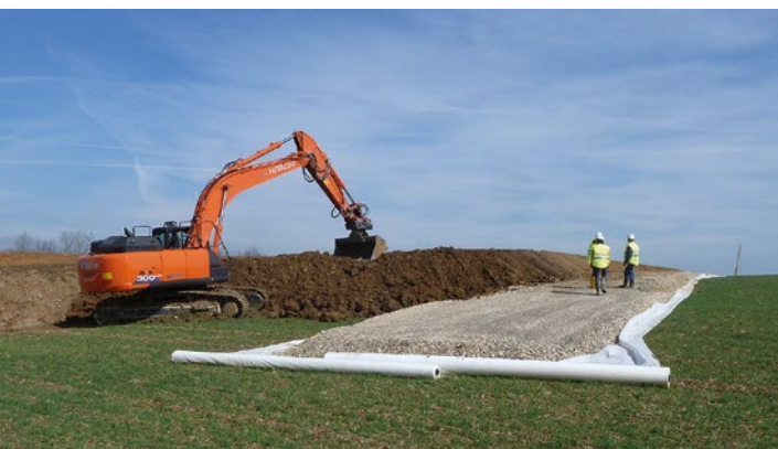
Merkblatt Bodenauffüllungen: Erstellen einer Oberbodenmiete mit Baustraße zur Anlieferung
